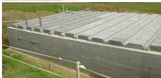
Fot. Strop nad przestrzenią wentylowaną z zastosowaniem stropów gęstożebrowych sprężonych z wypełnieniem w formie pustaka betonowego, drewnopochodnego oraz plastikowego z recyklingu.
