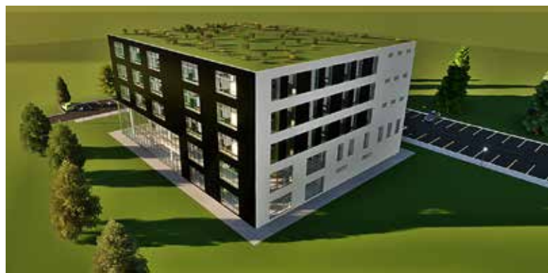
Rys. 3. Południowa elewacja oraz wizualizacja obiektu z widokiem na fotowoltaiczną fasadę i zielony dach
