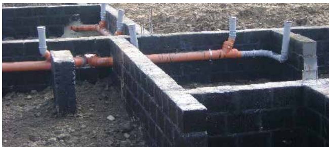
Fot. Strop nad gruntem
