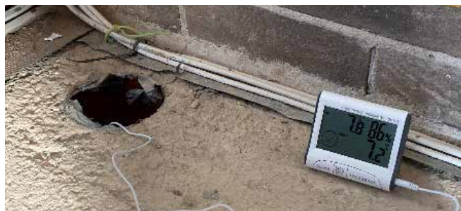
Fot. Pomiar temperatury przestrzeni wentylowanej, otwór wentylacyjny, opaska żwirowa.
