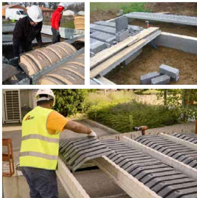
Fot. Montaż stropu na poziomie „0”
