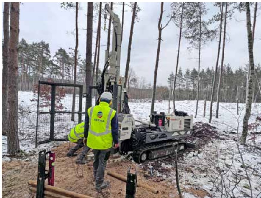
Wiercenia technologią direct push
