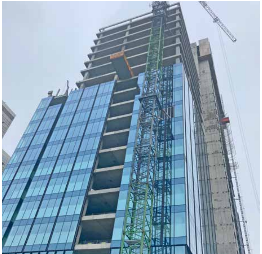
Na budowie Andersia Silver w Poznaniu, fot. Michał Wasilewski
