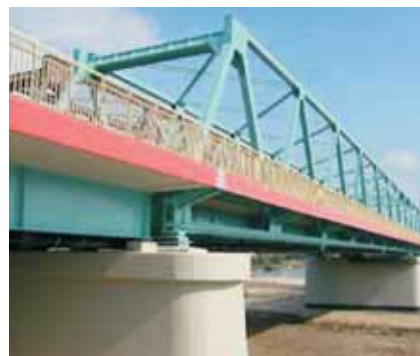
Most drogowy na Wiśle w Nagnajowie
