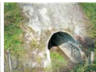
Przepust w m. Nienadowa w ciągu drogi krajowej nr 28
