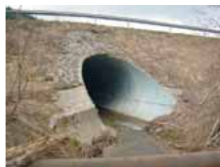
Przepust w m. Żłobek w ciągu drogi wojewódzkiej nr 896
