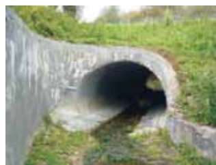
Przepust w m. Krasiczyn w ciągu drogi krajowej nr 28
