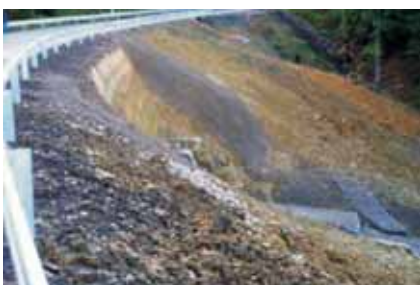
Osuwisko w Polanie po zabezpieczeniu
