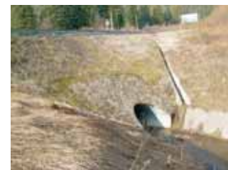
Przepust w m. Cisna w ciągu drogi wojewódzkiej nr 893L
