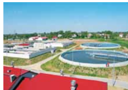
Oczyszczalnia ścieków w Mielcu
