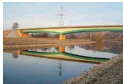
Most na Wisłocie w miejscowości Jaworze Górne
