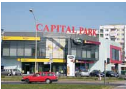
Budynek biurowo-handlowy z podziemnym parkingiem „CAPITAL PARK” przy ul. Rejtana w Rzeszowie
