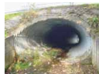
Przepust w m. Nienadowa w ciągu drogi powiatowej
